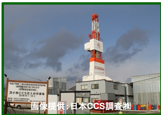
CCS圧入井の掘削作業
