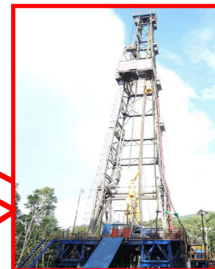
武佐岳地域での掘削作業
