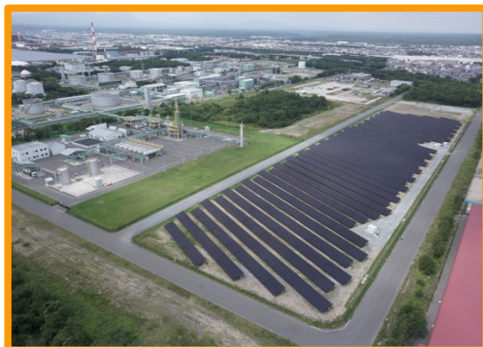
北海道鉱業所メガソーラー発電所
