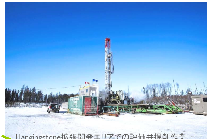
Hangingstone拡張開発エリアでの評価井掘削作業
