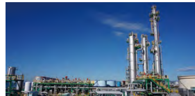
北海道 苫小牧実証プロジェクト地上設備 写真提供:日本CCS調査(株)
