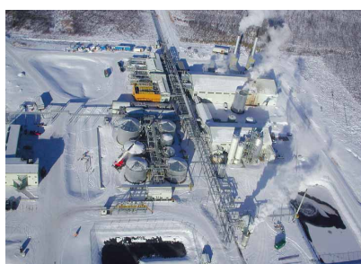
オイルサンド生産プラント(アルバータ州)
