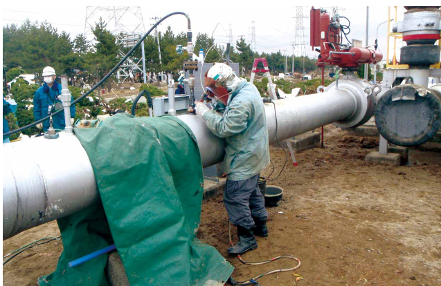
パイプライン地上設備復旧作業
