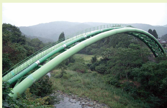
新潟・仙台間ガスパイプラインガス管橋
