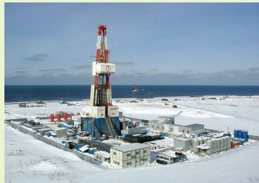
陸上掘削リグ（北海道）
