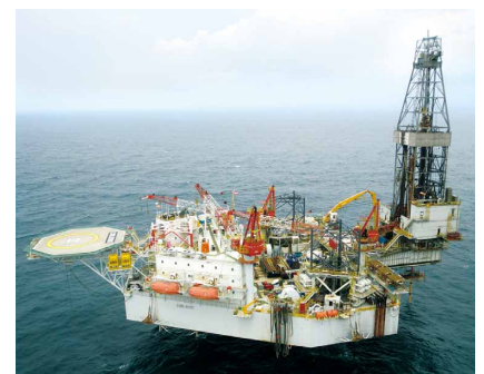
TSBガス田のジャッキアップリグ
