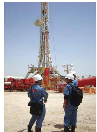
現地での掘削作業
