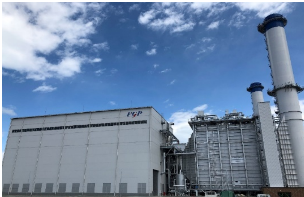
福島ガス発電(株) 福島天然ガス発電所1号機外観
