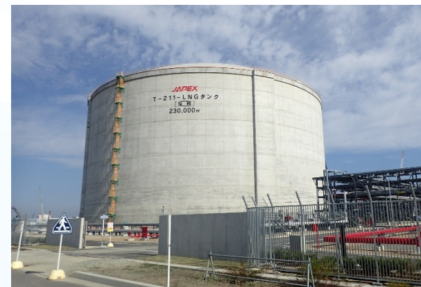
相馬LNG基地
