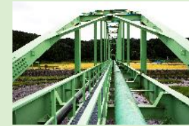
高圧ガスパイプライン 建設・操業
