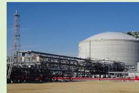
相馬LNG基地など LNG基地建設・操業
