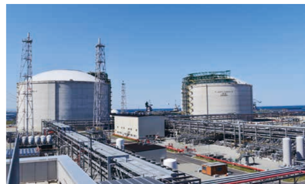
△ Soma LNG Terminal
