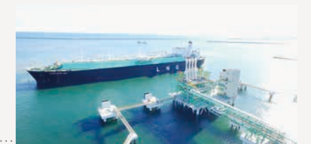
△ Soma LNG Terminal first cargo
