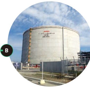
Soma LNG Terminal
