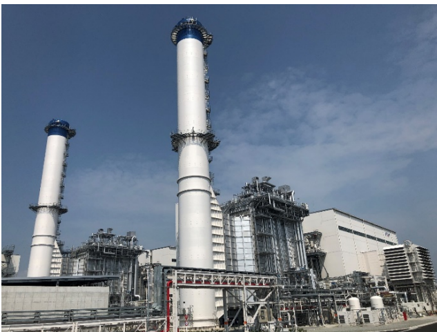
発電所地上から (右手前が2号機、左奥が1号機)
