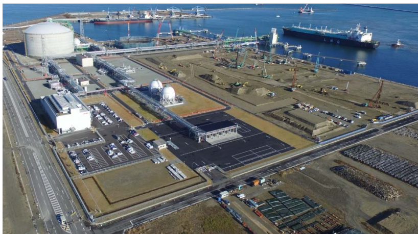
相馬 LNG 基地全景 (2017 年 12 月 6 日時点)
