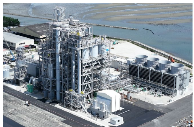
本発電所外観
