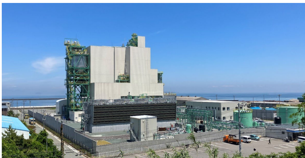
（大洲バイオマス発電所 全景）
