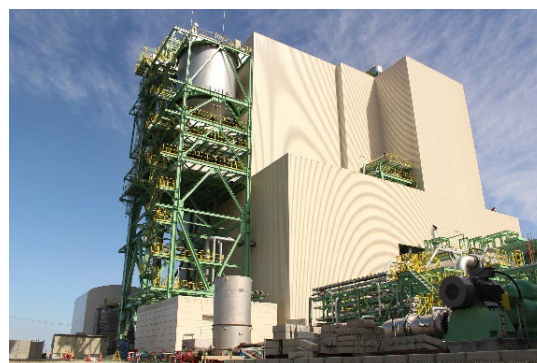
大洲バイオマス発電所全景
