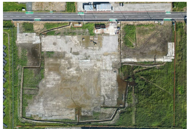
(発電所建設地空撮：2022年9月撮影)
