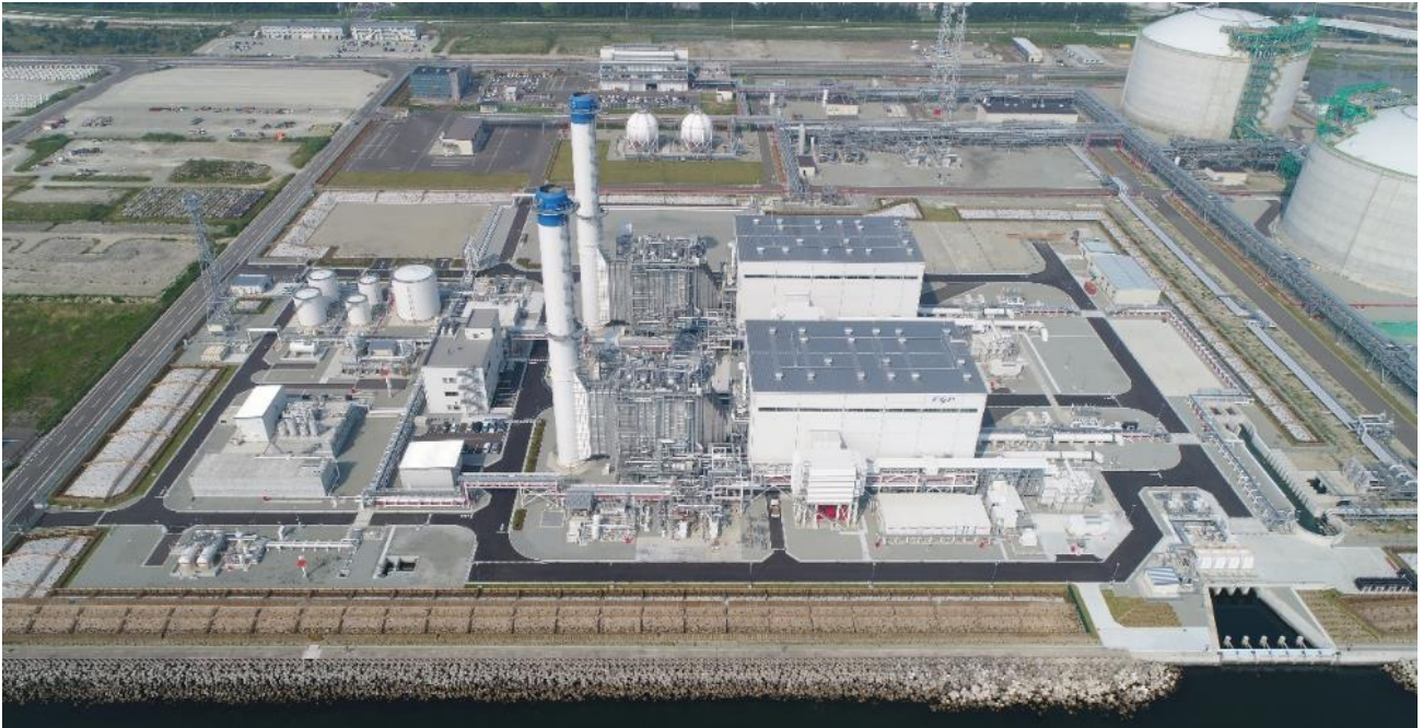
発電所全景 (右～奥は JAPEX 相馬 LNG 基地)
