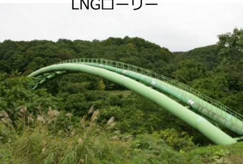
新潟・仙台間ガスパイプライン
