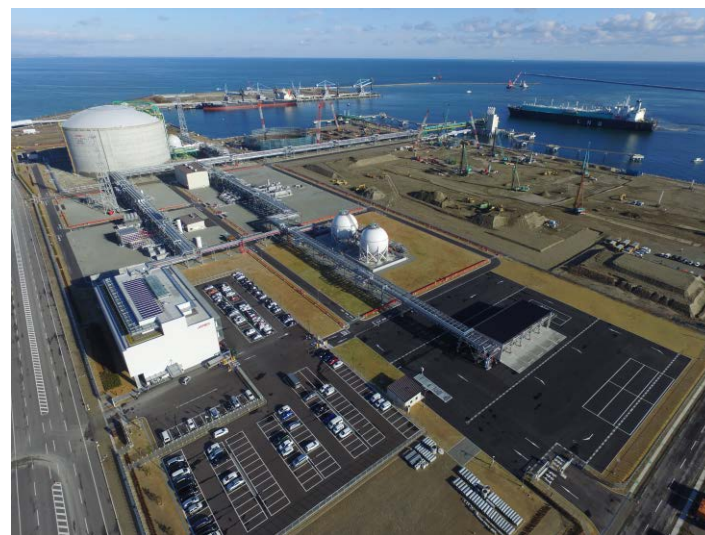
△相馬LNG基地全景
