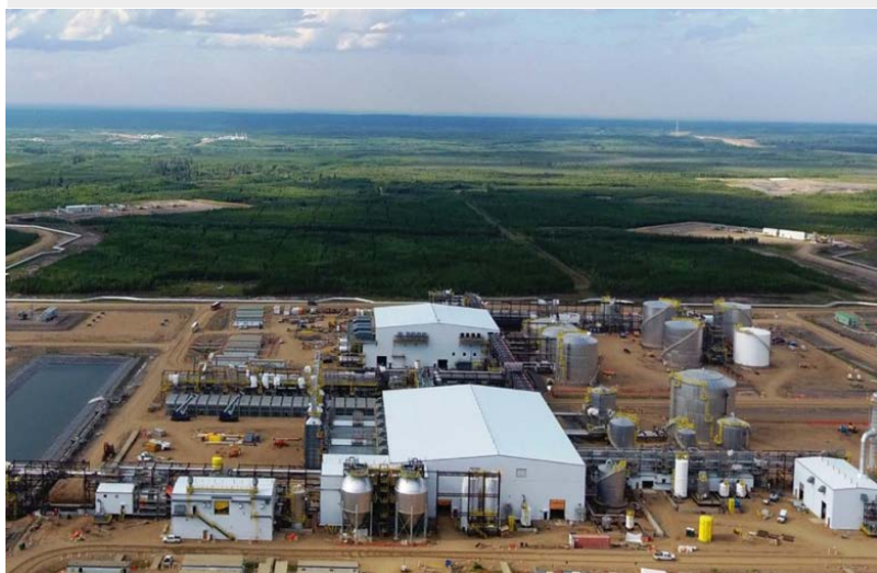
△ハンギングストーン拡張開発 中央処理施設(CPF)全景
