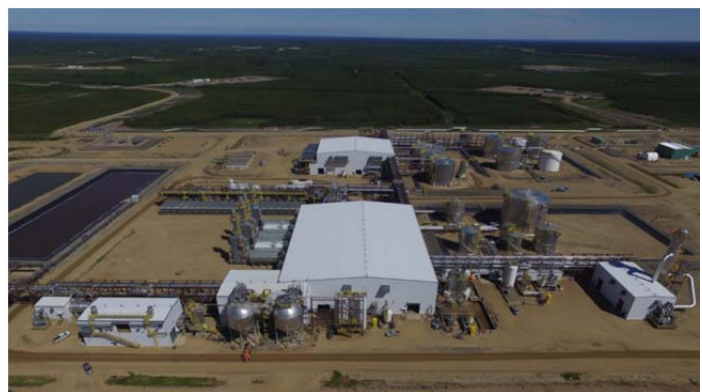
写真右：拡張開発事業中央処理施設全景
