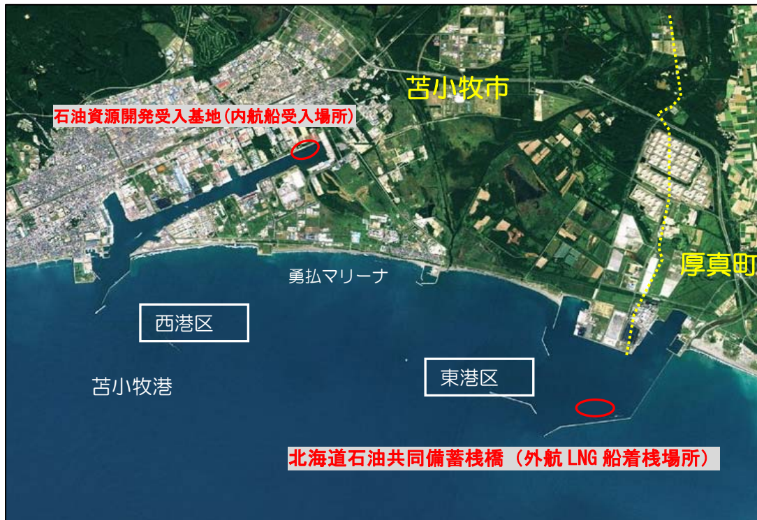
北海道石油共同備蓄(株)棧橋及び石油資源開発 2 号岸壁の位置(苫小牧港全景)
