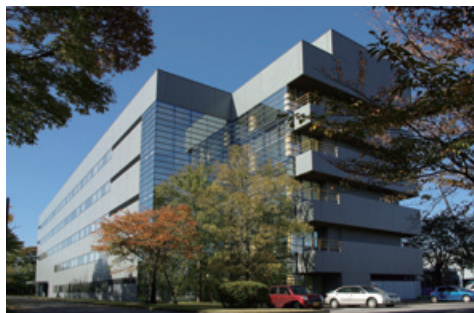
蓄電所を設置する技術研究所
