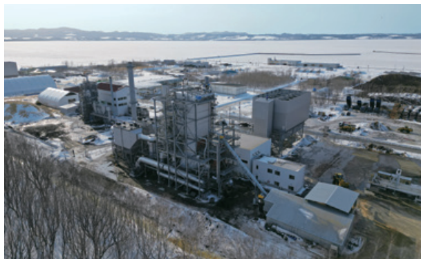
網走バイオマス発電所2号機
