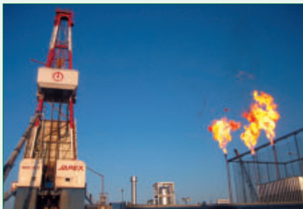
採掘井の掘削作業(北海道 勇払油ガス田)
