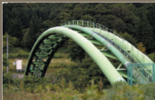
新潟・仙台間ガスパイプライン
