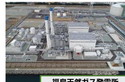
福島天然ガス発電所
