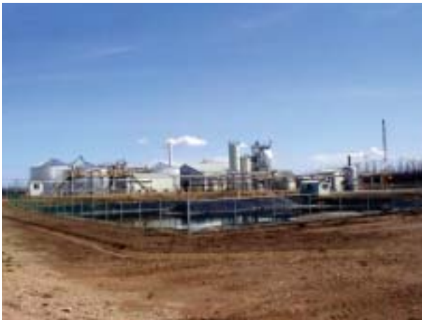
カナダオイルサンド(株)生産設備
