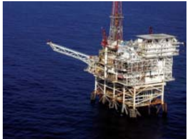
新南海石油開発(株)Lufeng 13-1油田生産プラットフォーム
