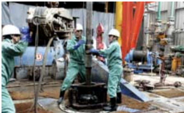
掘削装置(ドリリング リグ)と掘削作業
