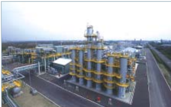
勇払油ガス田生産処理設備（北海道苫小牧市）
