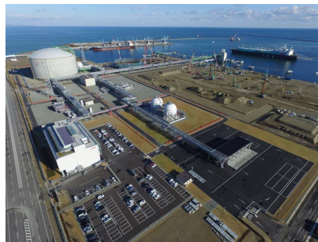
△Bird view of the Soma LNG Terminal
