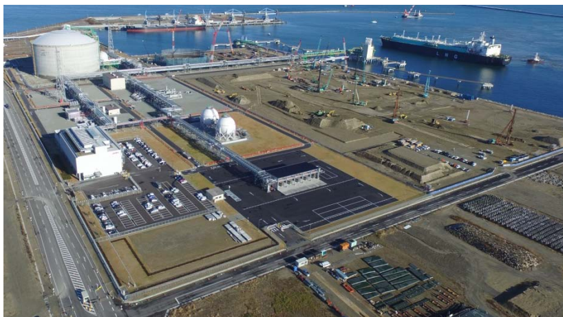
相馬 LNG 基地全景 (2017 年 12 月 6 日時点)
