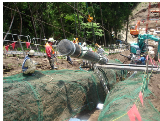
建設中の白石・郡山間ガスパイプライン
