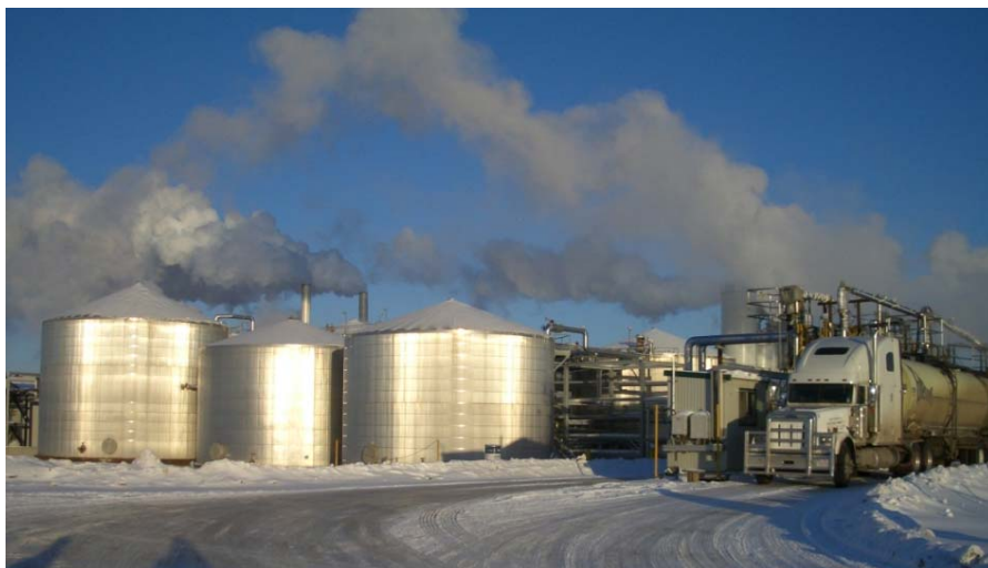
JACOS ビチューメン処理設備
