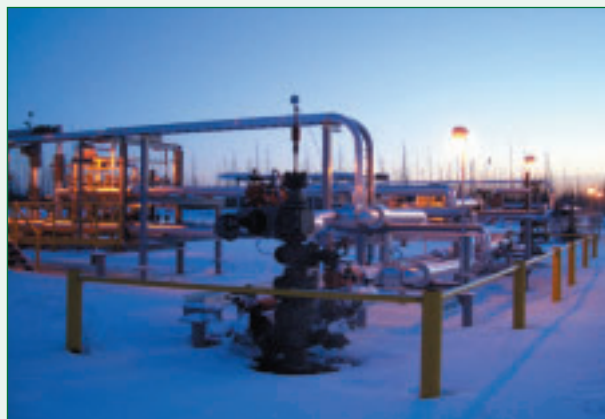
オイルサンド生産操業サイト(カナダ アルバータ州アサバスカ地域)
