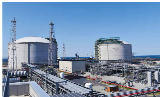
△ Soma LNG Terminal
