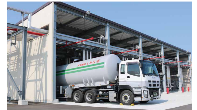
△ LNG shipping facility for tank trucks at the Soma LNG Terminal
